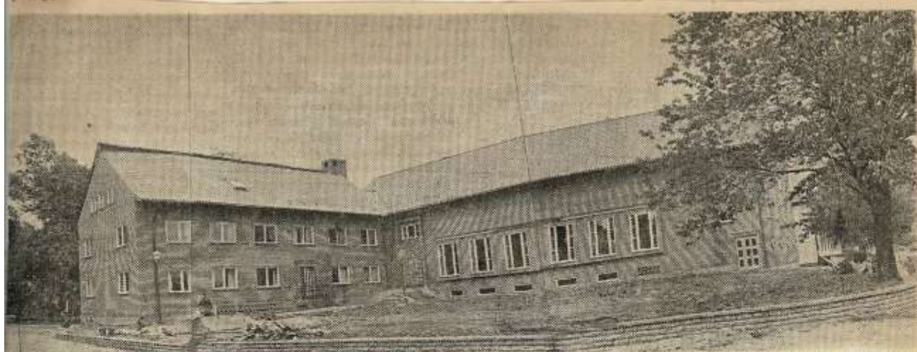
Kristnkyrkan och en nylagd trappa förbinder direkt de bägge byggnaderna. I vinkelbyggnaden t.v. är pastoraexpedition och bl.a. kommissionärerna, organistens vaktmastarens bostäder inrymda. I den andra vågen finns bl.a. församlingssalen.
