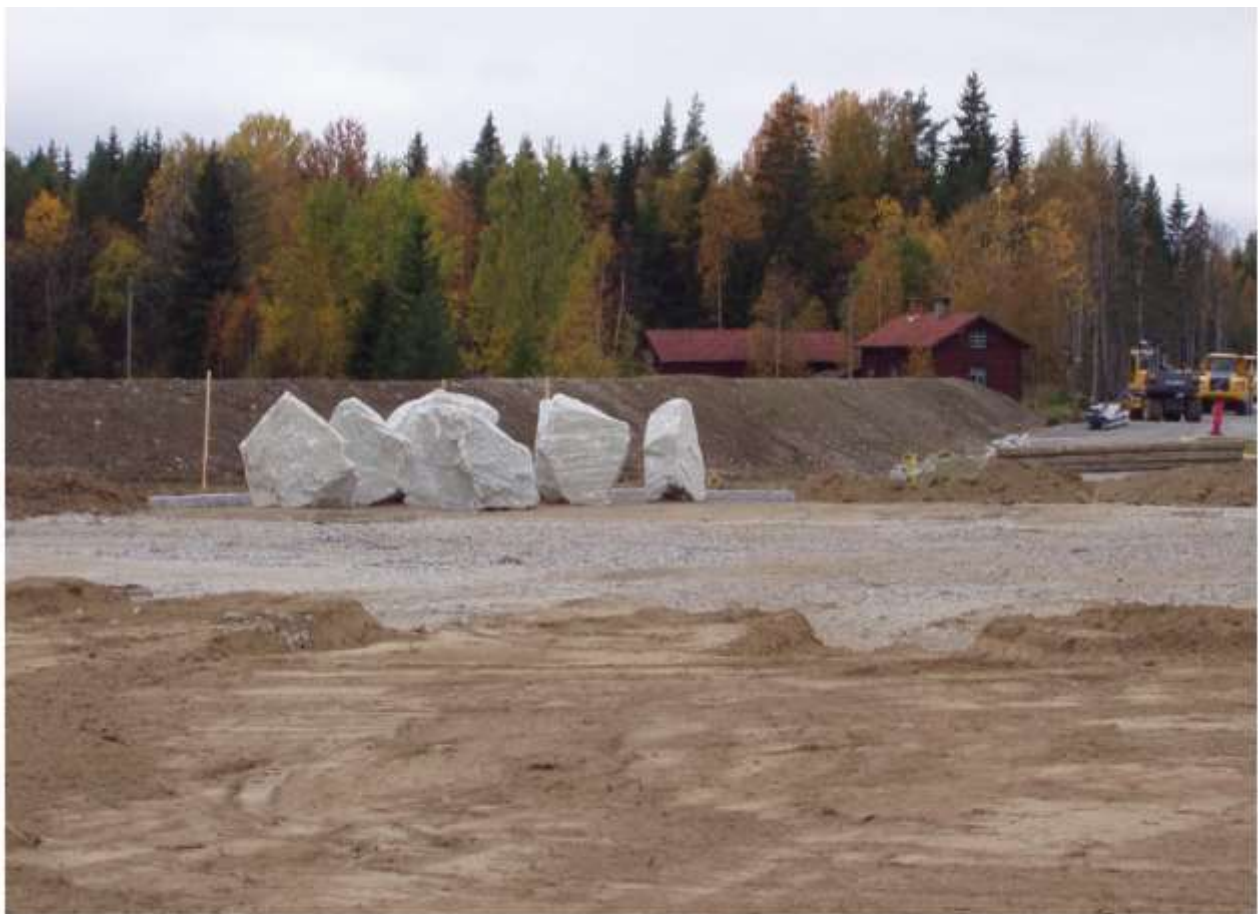
Inzoomad bild på stenuppställning mot bullervall. Vägen mot Mora skimtar till höger. Vid slutlig uppställning kommer inte glipor att synas. Stenarna bör justeras slutligt. På den nedre bilden ser man rondellen från Morahållet i riktning av ny väg mot SörKivsta.
