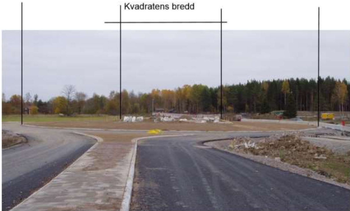
I riktning mot Sala från Västerås. Stående stenar till vänster. Här ser man hela rondellens diameter och den inre kvadratens bredd. Den senare skulle kunna minskas.
