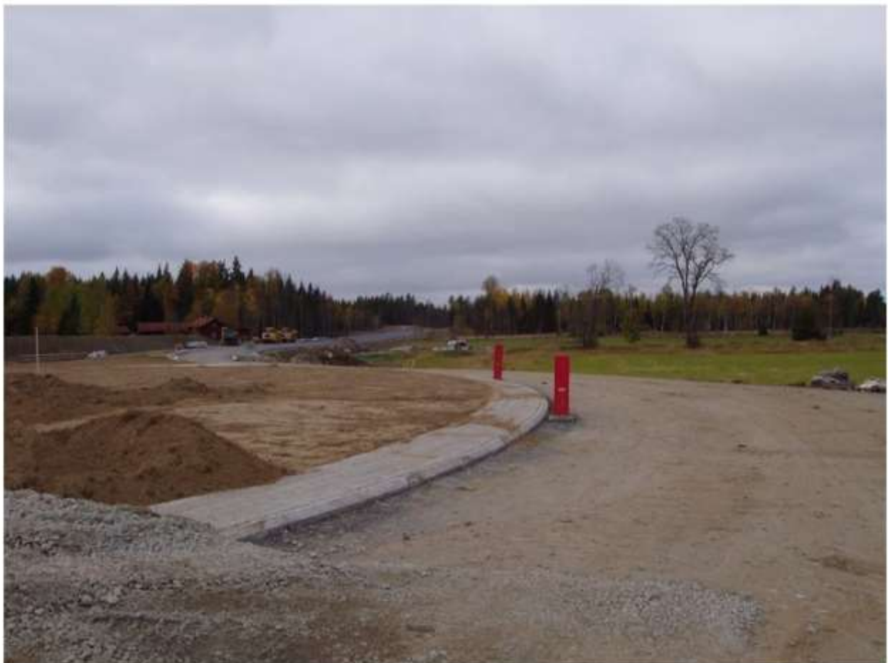
Kantsten runt rondellen.
