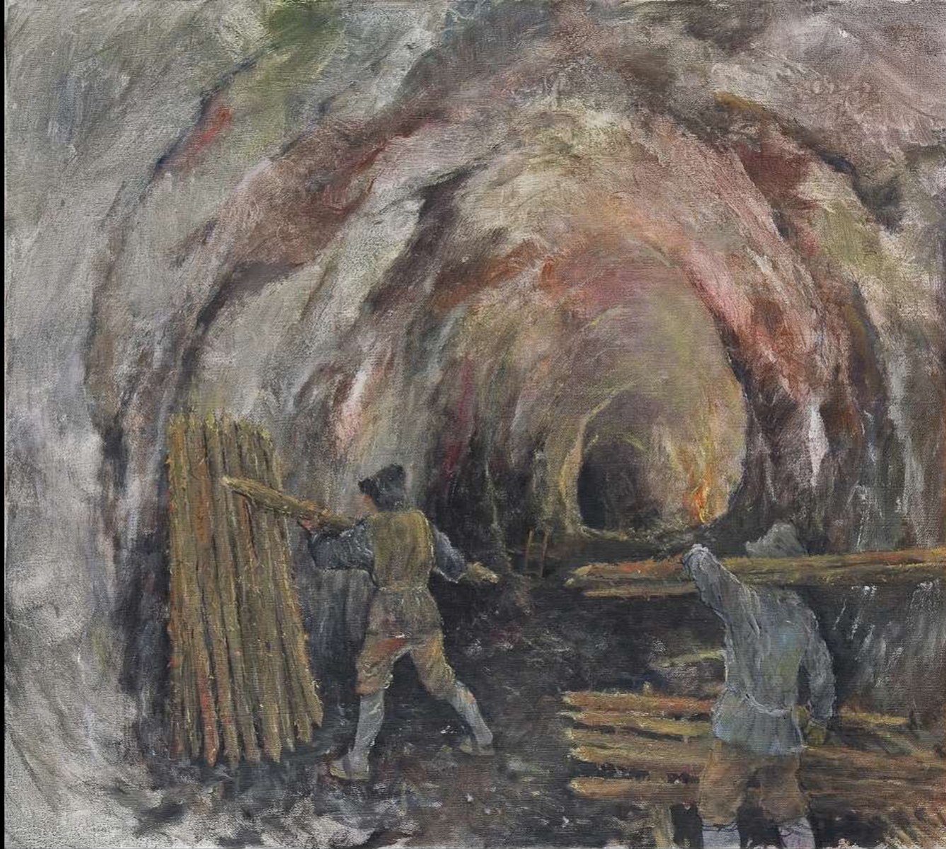
Vägglave för sprängning restes mot bergväggen. Tätt samman med smaländan nedåt för bättre drag.
