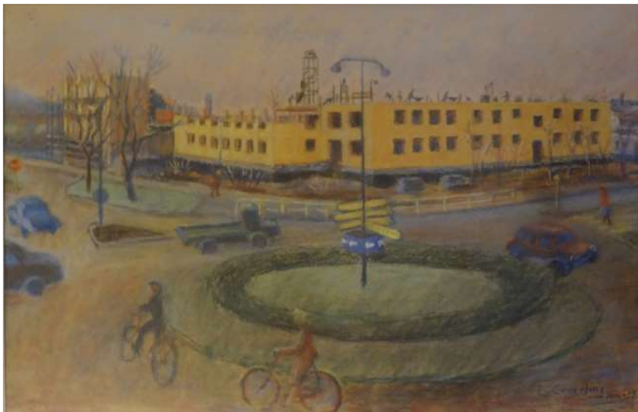
Edvard Cederling, Tingshuset under byggnad , November -58, pastell 40 X 62 cm.
