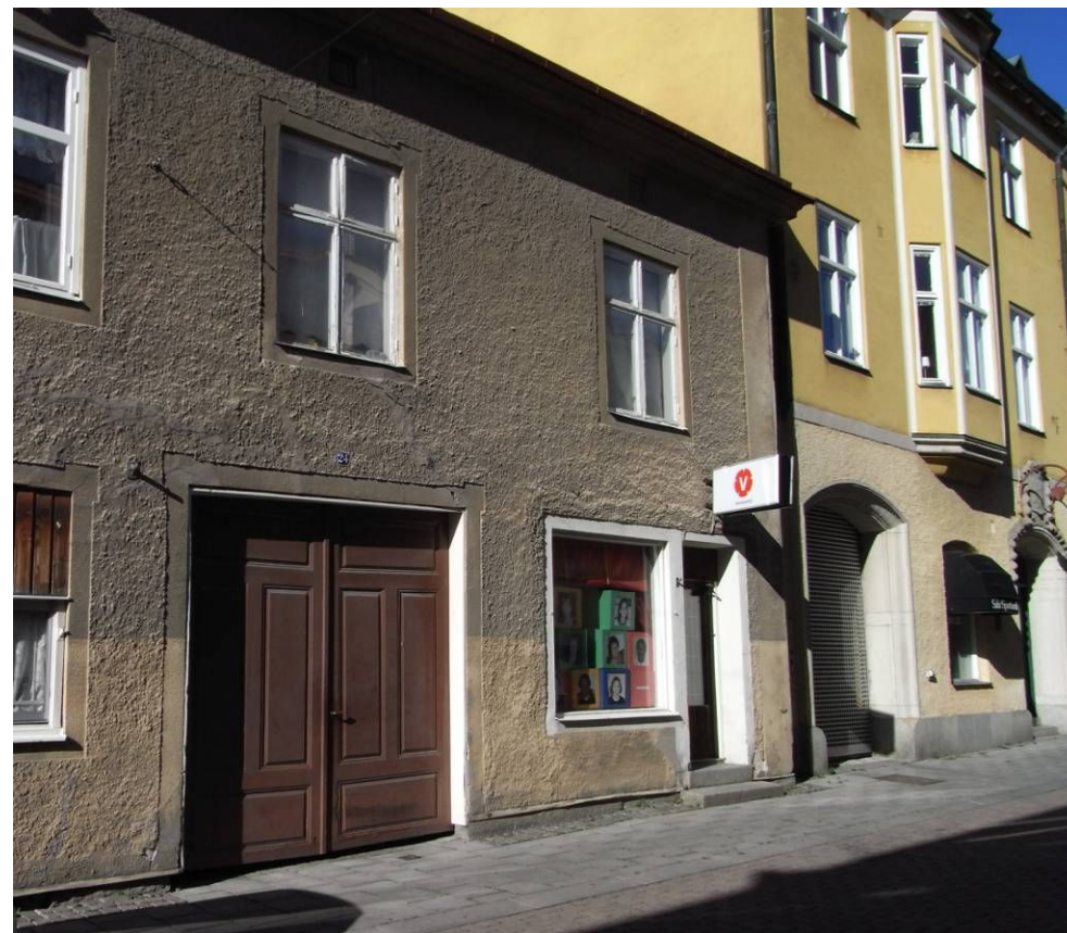
Fredsgatan 24 där Vänsterpartiet har sin lokal idag, 2010. Enligt ansökningsbrevet på föregående bild var adressen till filialen Fredsgatan 24, men enligt annonsen ovan t.v. var filialen i Sparbankshuset, i så fall i den högra byggnaden. Den första porten i Sparbankshuset leder in till gården. Porten längst till höger har adressen Fredsgatan 22 idag. Foto Johnny Ekman.
