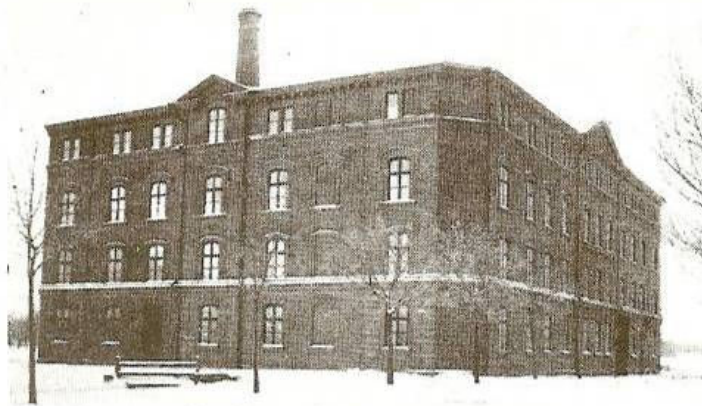
Sala Ångkvarn, nuvarande Sveahuset.
