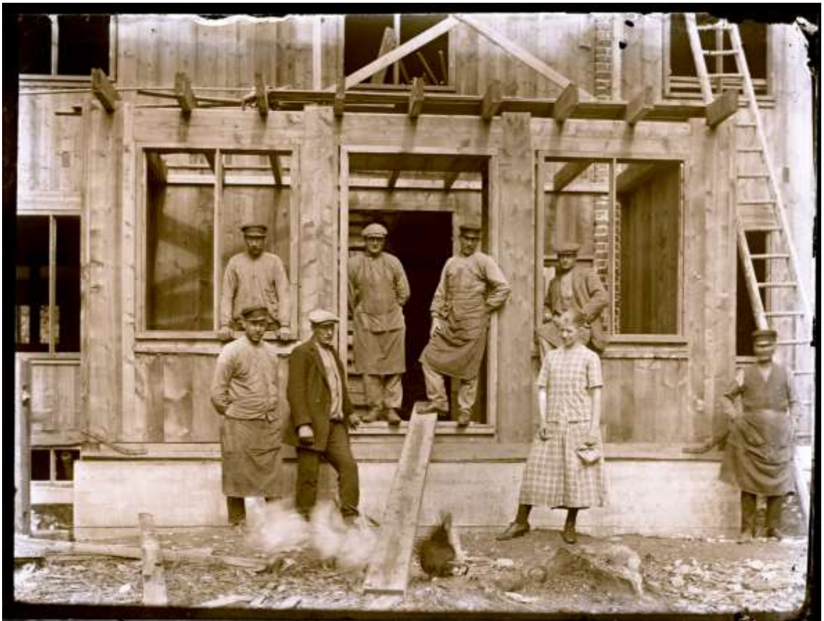
Arvid Andersson, Vid gruvan runt 1915. Bygge av hus, foto.
