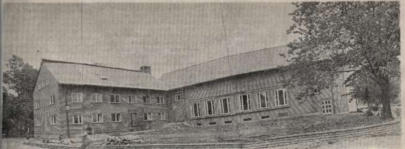
Kristinakyrkan och en nylagd trappa förbinder direkt de bägge byggnaderna. I vinkelbyggnaden t.v. är pastorsexpedition och bl.a. kommissionens, organistens vaktmästarens bostäder inrymda. I den andra kungan finns bl.a. församlingssalen.
