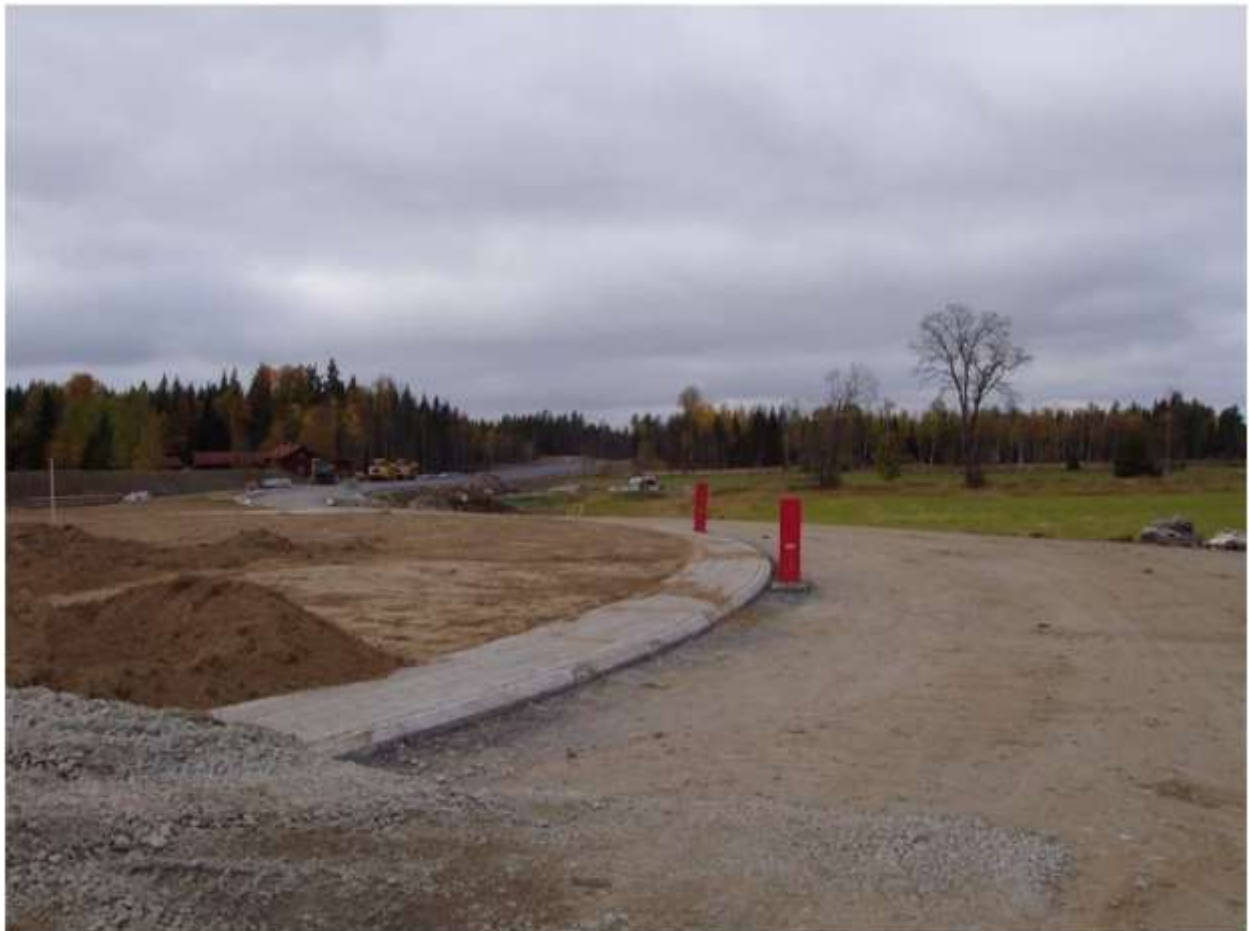
Kantsten runt rondellen.
