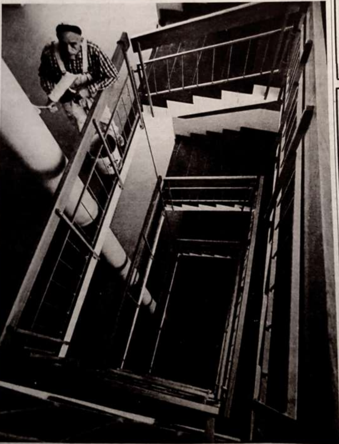
En febril verksamhet råder just nu på Jakobsbergsgården — det är ännu många detaljer som skall klaras av innan det är inflyttningsklart. Här ses målare Joel Lindberg i arbete.
