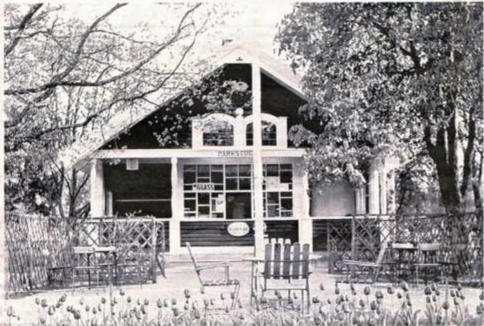
DET VAR EN GÅNG... Parkstugan var en idyll i 1950-talets sommar-Sala, med Grythytttemöbler under kastanjerna. Caféet fanns under ett drygt halvsekel och byggnaden revs 1982.
