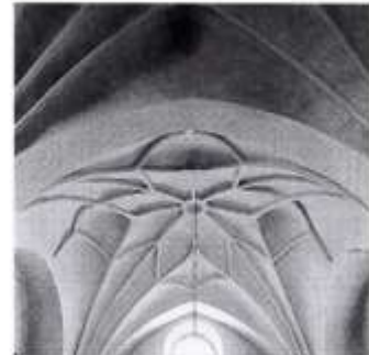
Västerfärnebo kyrkas valv är av typen "Vadstenastjärna". Namnet kommer från valven i Vadstena klosterkyrka som välvades omkring 1420.
